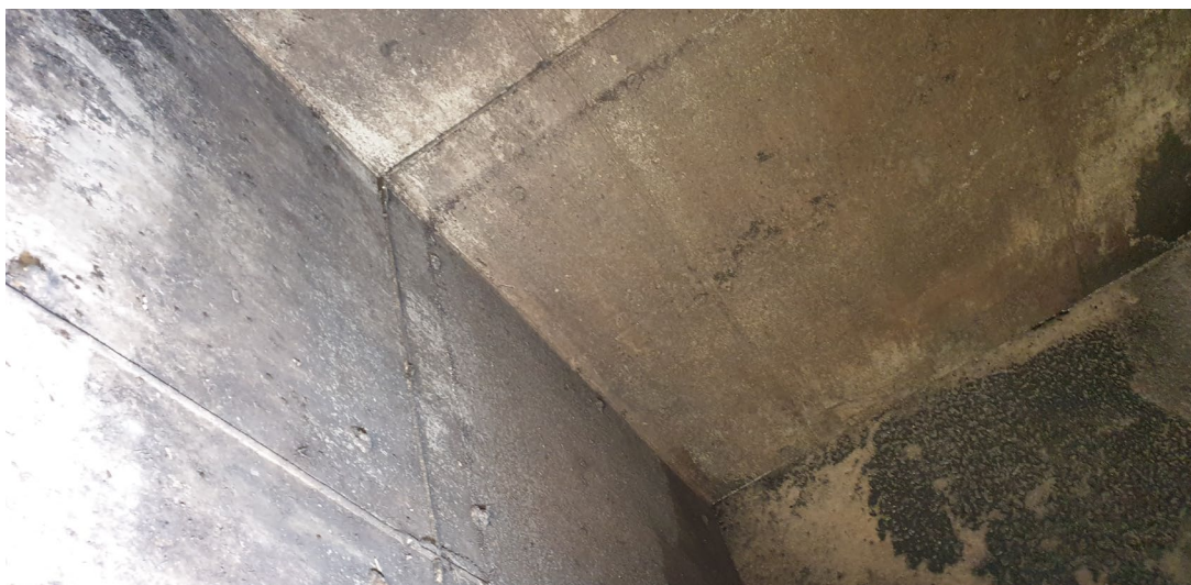
Fot. 7. Widok wnętrza zbiornika i okładziny ścian z płyt PEHD
