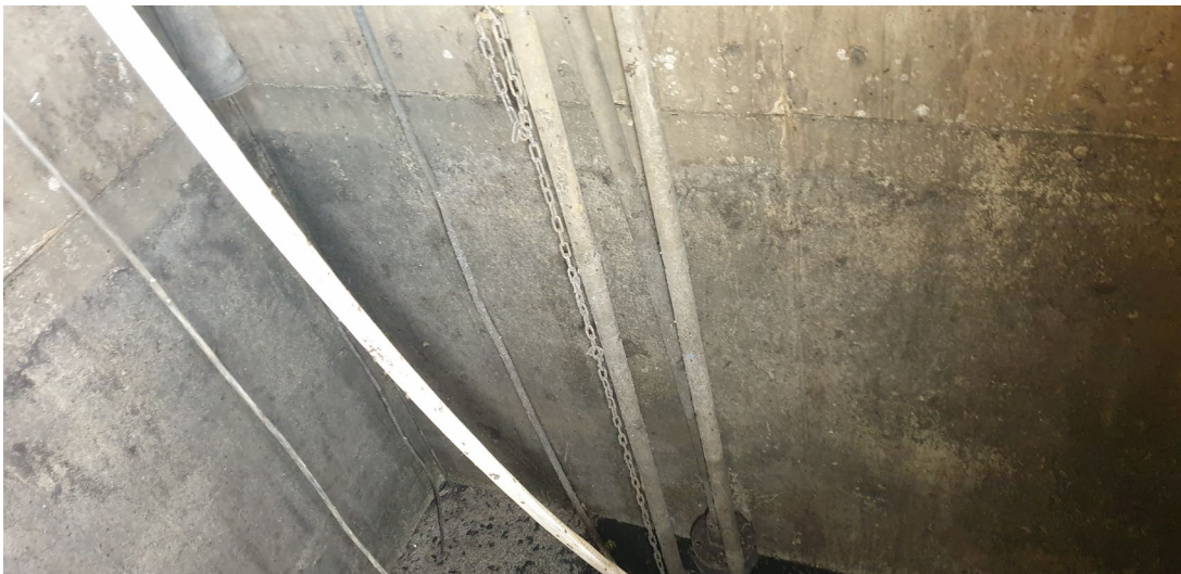
Fot. 6. Widok wnętrza zbiornika i okładziny ścian z płyt PEHD
