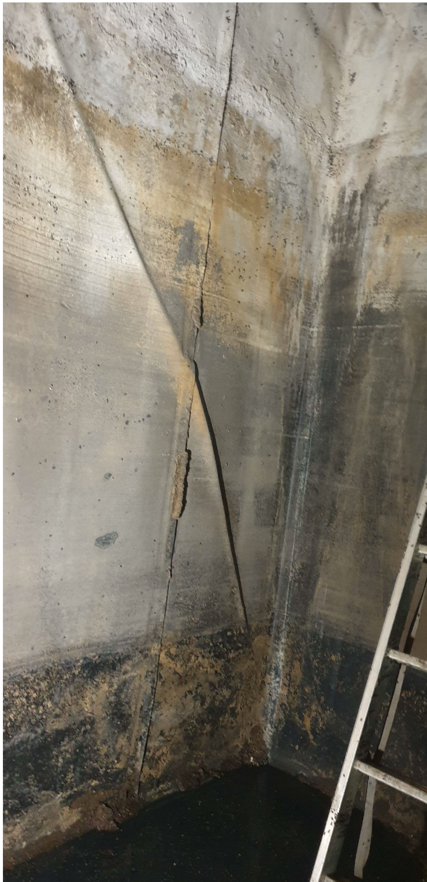
Fot. 14. Widok ścian zbiornika zabezpieczonych folią
