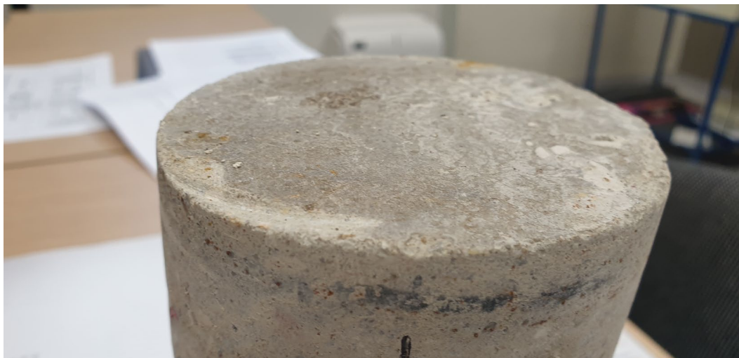
Fot. 20. Widok powierzchni górnej (zewnątrznej) próbki rdzeniowej nr 2
