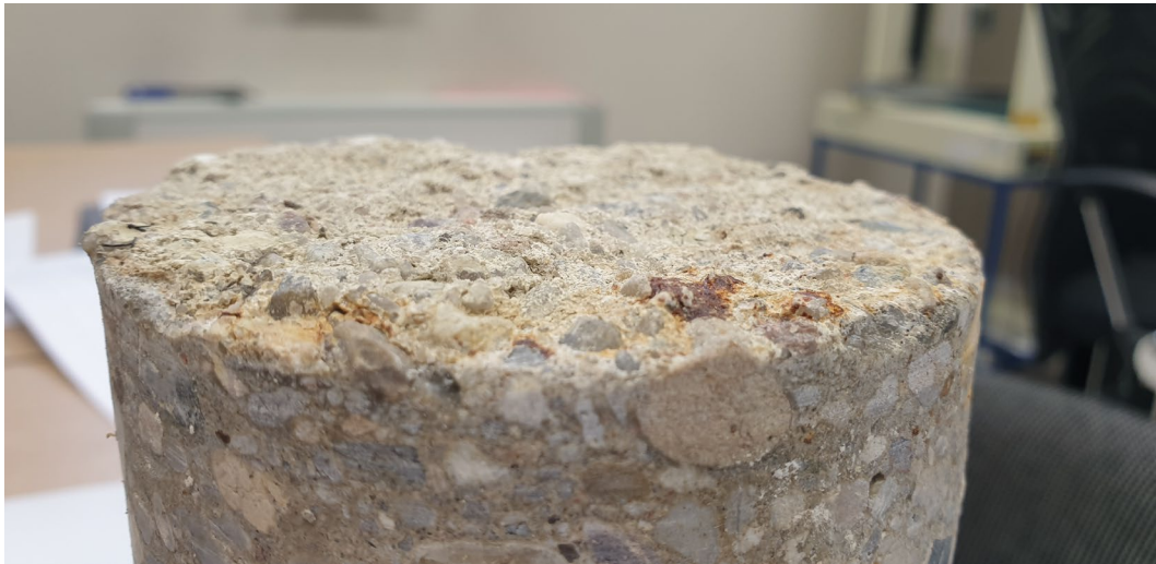
Fot. 21. Widok powierzchni dolnej (wewnętrznej) próbki rdzeniowej nr 2
