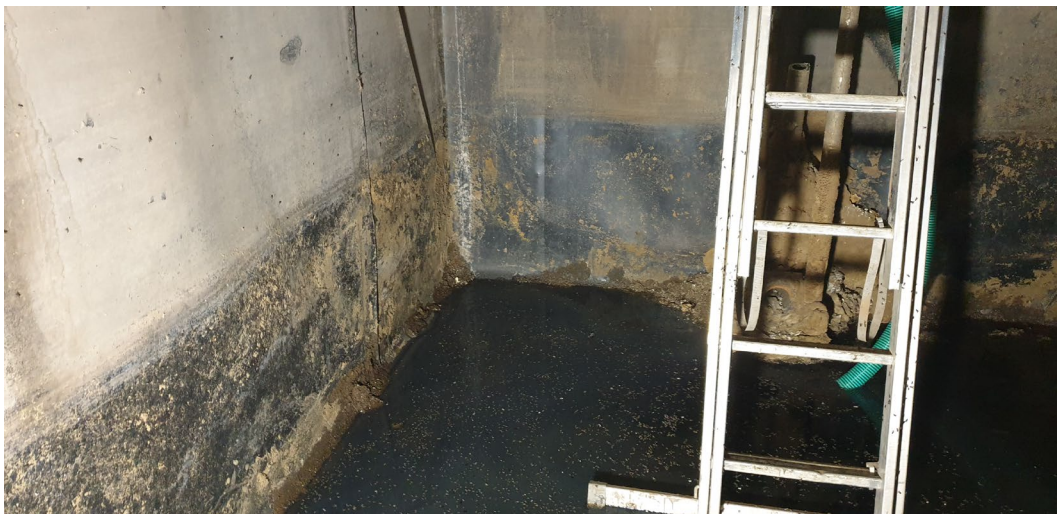
Fot. 10. Widok ścian zbiornika zabezpieczonych folią
