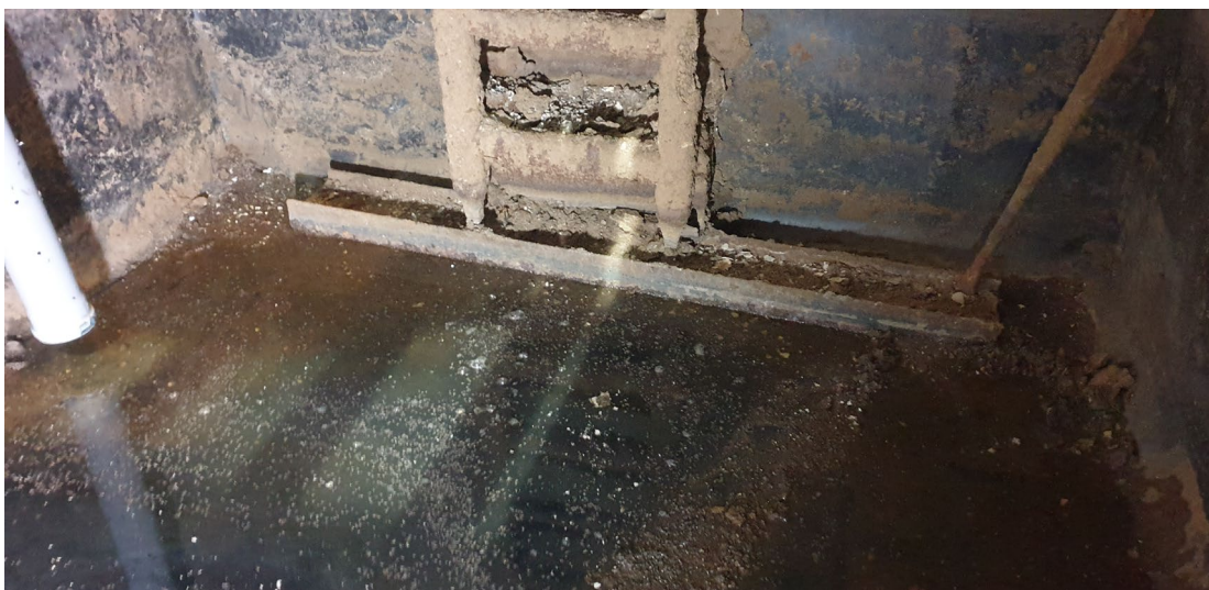
Fot. 13. Widok dna zbiornika i oparcia drabiny na dnie
