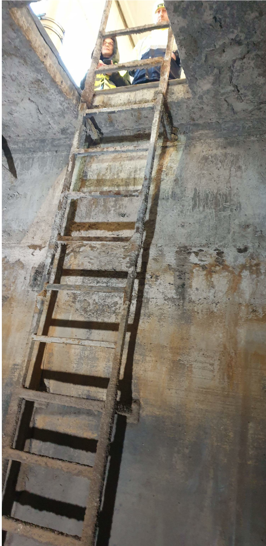
Fot. 15. Stan drabiny stałej
