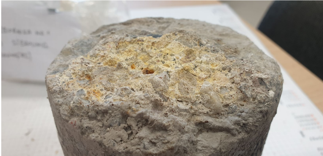
Fot. 18. Widok powierzchni dolnej (wewnętrznej) próbki rdzeniowej nr 1
