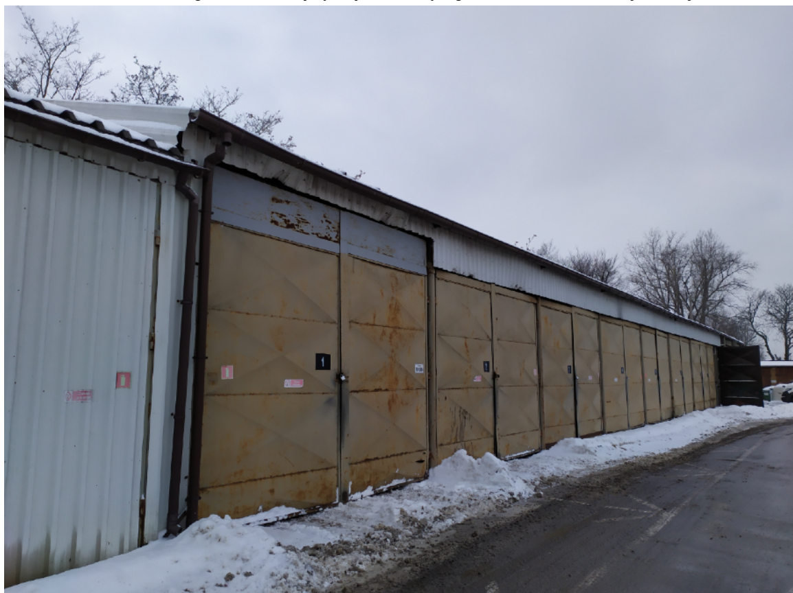
Fot. 6 Elewacja frontowa od strony budynku technicznego – liczne ogniska korozji bram, uszkodzenia mechaniczne poszycia ścian.
