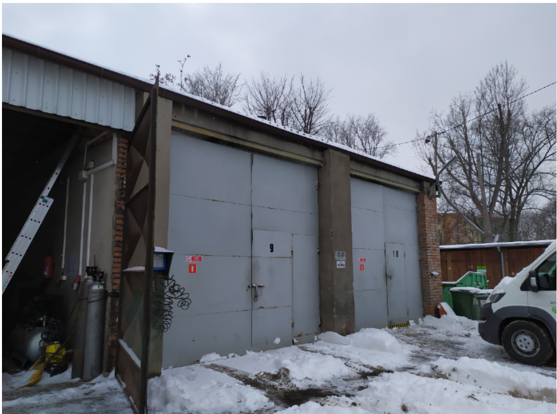
Fot. 3 Część murowana budynku – nieprzeznaczona do rozbiórki
